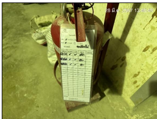
ภาพที่ 37 การตรวจสอบอุปกรณ์ดับเพลิง
